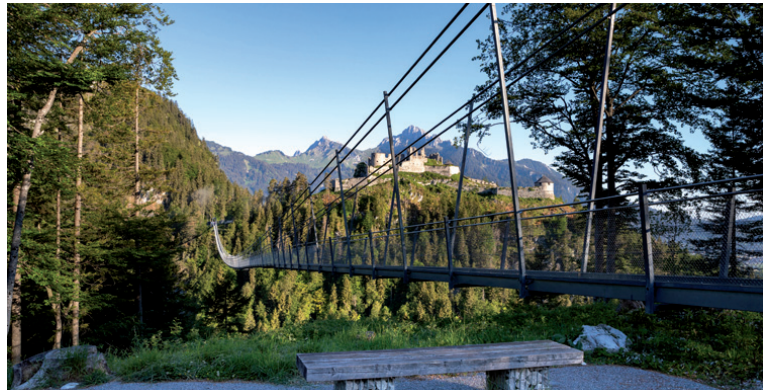
Fußgängerhängebrücke highline179 und Burgenwelt Ehrenberg
